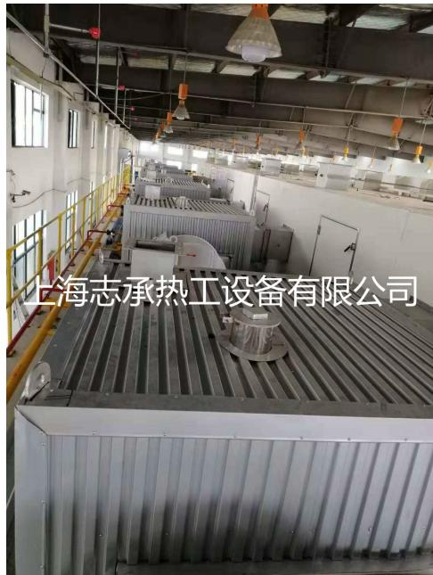
由于余热气含尘量大，含有较多腐蚀性物质，更易造成锅炉积灰、腐蚀、磨损等问题，因此防积灰、磨损是设计余热锅炉的关键。直通式炉型、大容积的空腔辐射冷却室、设置的密封炉墙、除尘室、大量振打吹灰装置都是余热锅炉为解决积灰、磨损问题在结构上的考虑。另外由于受工艺生产场地空间限制，余热锅炉把换热部件分散安装在工艺流程各部位，而不是像普通锅炉一样组装成一体。近十年随着节能减排工作的推进，国内主要余热锅炉设计制造企业获得加速发展，余热锅炉为适应工业领域产能调整和增长，朝着大型化、高参数方向发展。
